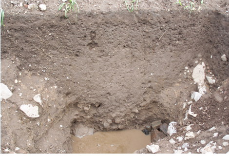
Ilustración 29. Se aprecia la excavación concluida, se llegó a más de 4 m de profundidad, y manaba abundante agua. Fotografía Pavel C. Leiva García
