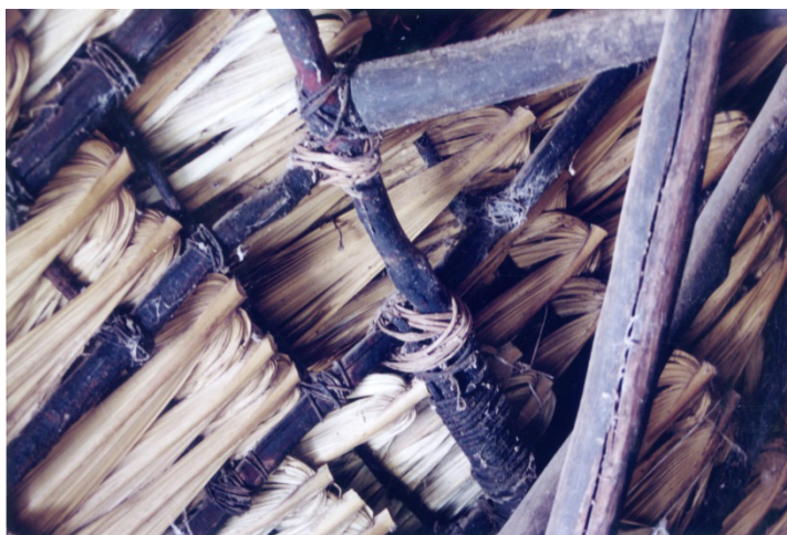
Figura 6. Detalle del amarre con bejuco. Fuente: Tomada por el autor, 2001.
